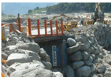
圖 3.19 陳有蘭溪簡易鋼板便橋（艾利颱風後）
